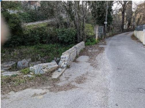
**Réfection des parapets** des ponts au-dessus du cadereau donnant accès au chemin de Combe Sourde et au chemin du Mas de Roulan. Ces parapets avaient été partiellement détruits par des véhicules
