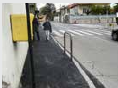
Réfection trottoir route d'Uzès
